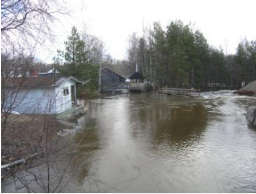
KUVA 10. Reinikkalan säännöstelypato tulvauomineen (Tapaninen 2005)
