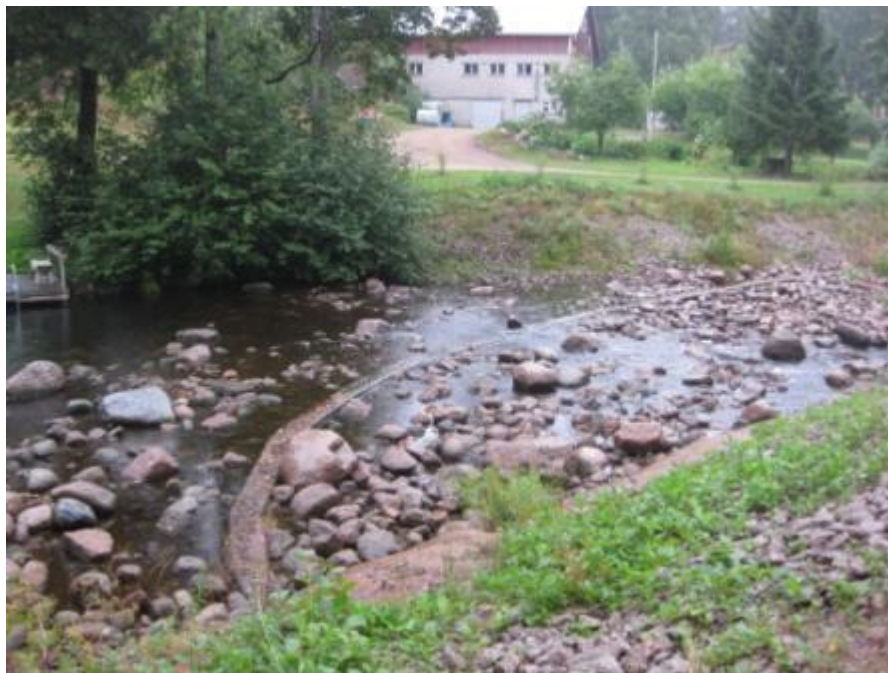
KUVA 20. Turpaan pohjapato alavirtaan päin (Laine 2013)
