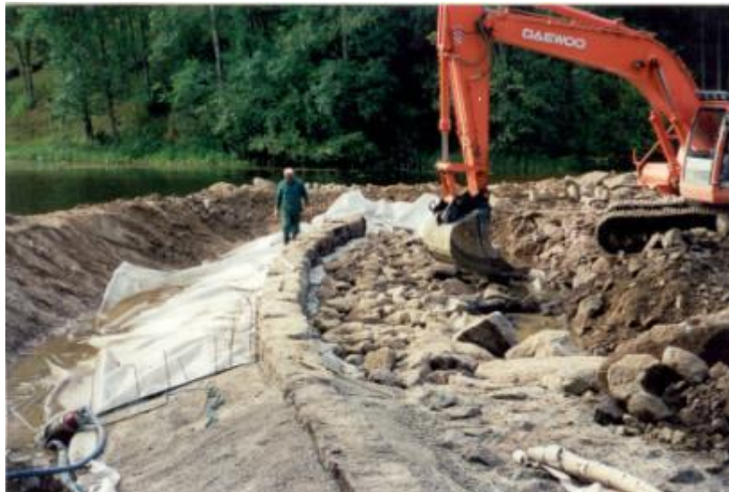
KUVA 8. Jokelan pohjapadon rakentamista työpadon suojassa (Leppikangas 1999)
