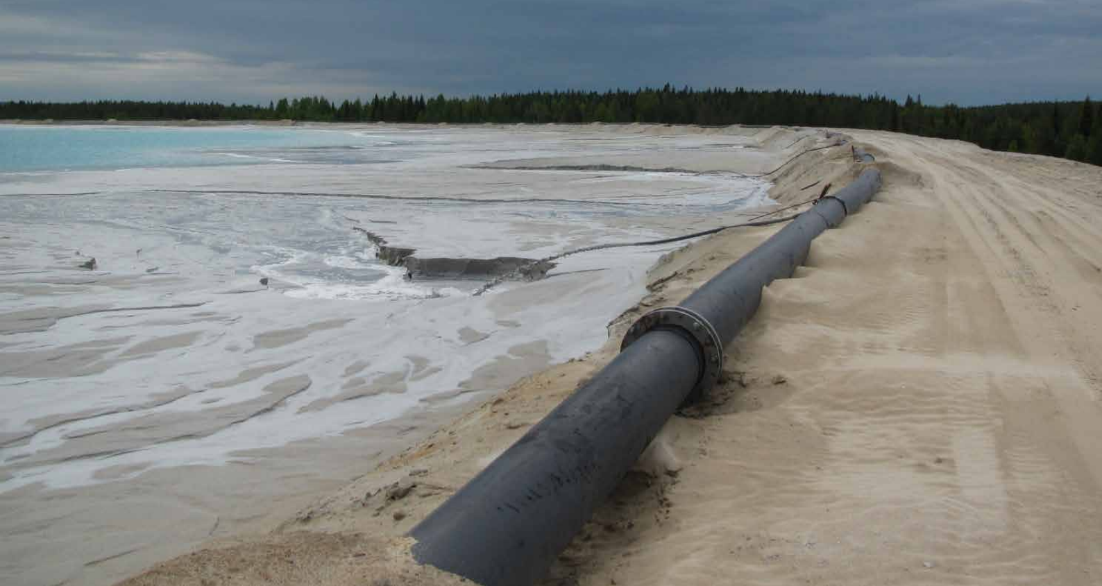
Rikastushiekalla korotettu kaivospato, 2012 (Timo Regina)
