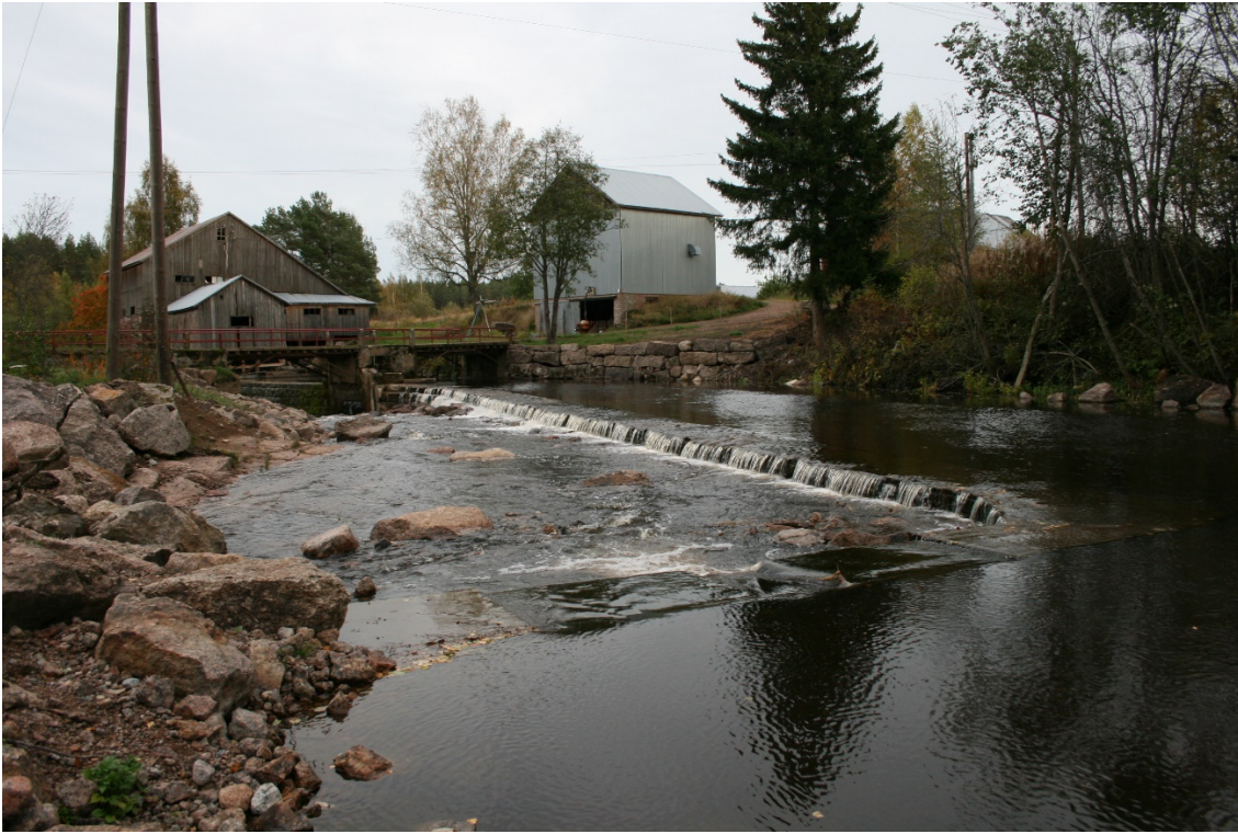
Kuva 1. Vaalimaanjoen Mattilankoski 2.10.2015 (kuva Manu Vihtonen).
